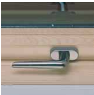
Una única manecilla, de aluminio, permite realizar todas las formas de apertura. La manecilla está provista de dos puntos de aireación (posición entreabierta).
